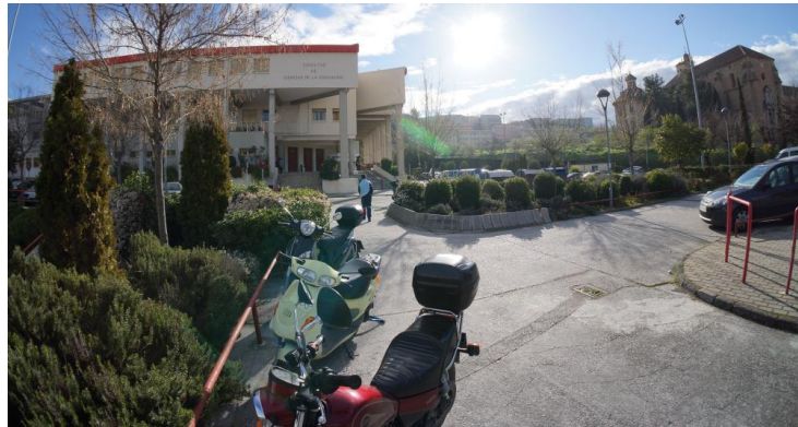
Entrada desde el aparcamiento bicicletas
