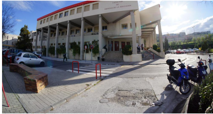
Entrada desde el aparcamiento esquina
